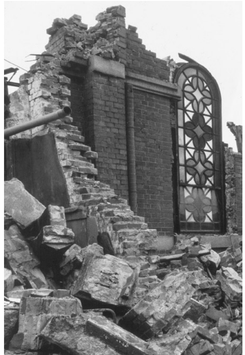
Maçonnerie non chaînée séisme de Kobé, 1995
