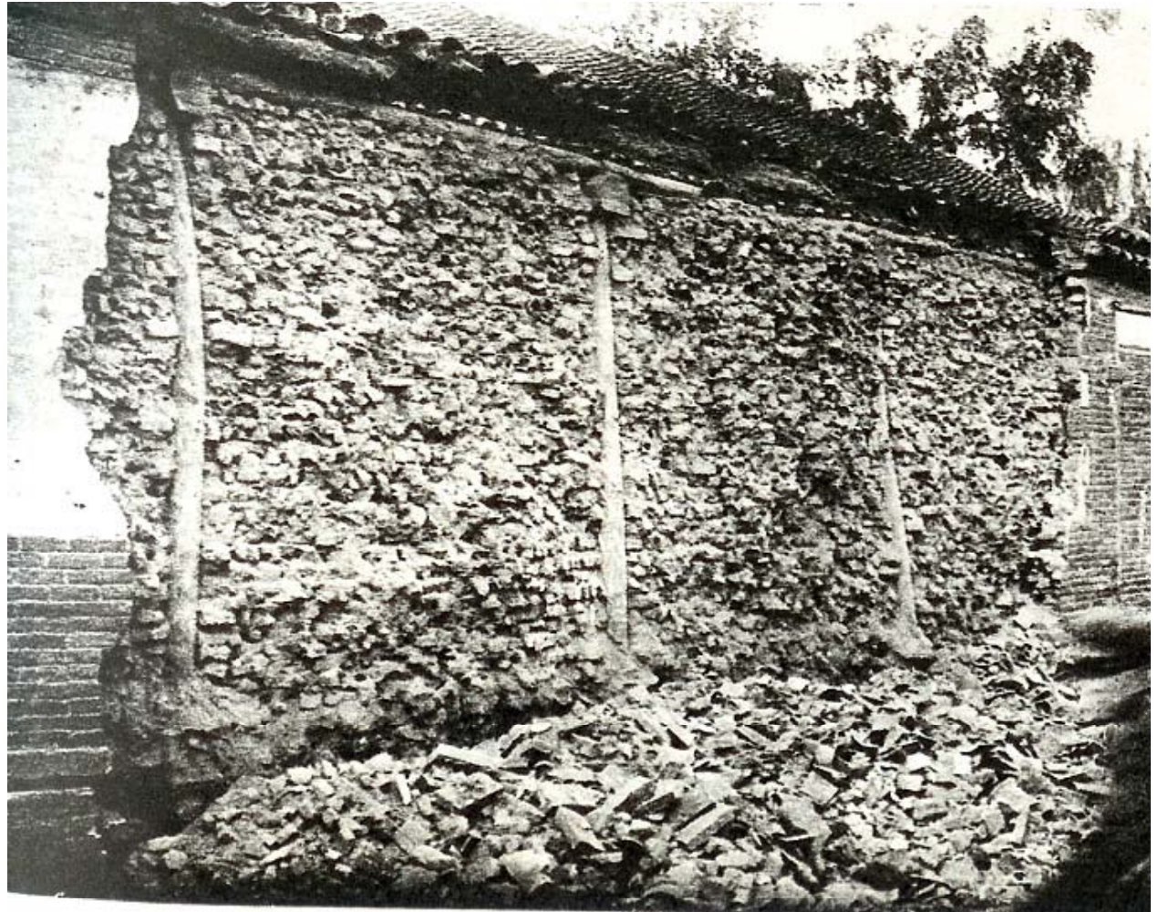
Tangshan / mur composite en briques et adobe
