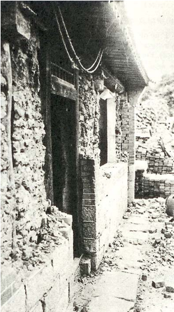
Tangshan / mur composite en briques et adobe
